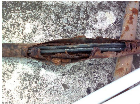
Fig. 2 Canalizacion para cables alimentadores de tableros de distribución
