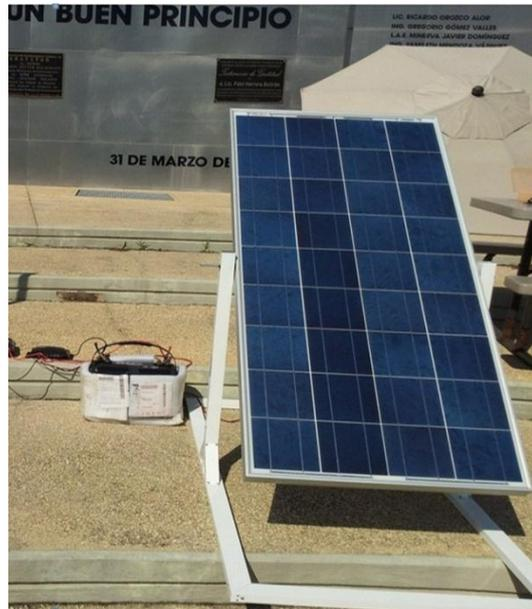
Fig. 11 Conexión del panel solar con el controlador y la batería.
