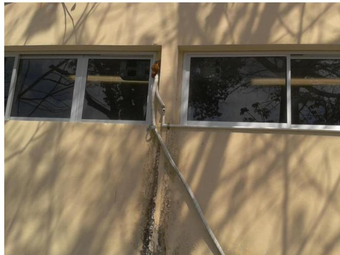
**Ilustración 2, Bajante de agua de condensados de aire acondicionado.**
