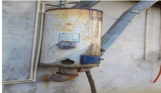
Figura 1. Calentador de agua instalado en función de un brasero (fogón).
