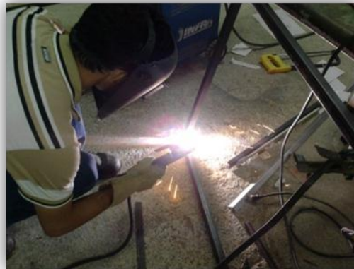
Figura 8: Soldadura de marco estructural.
